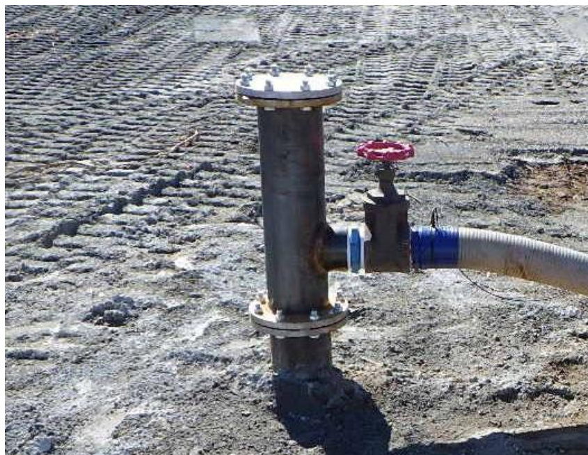
写真 1 地上部仕上がり状況
